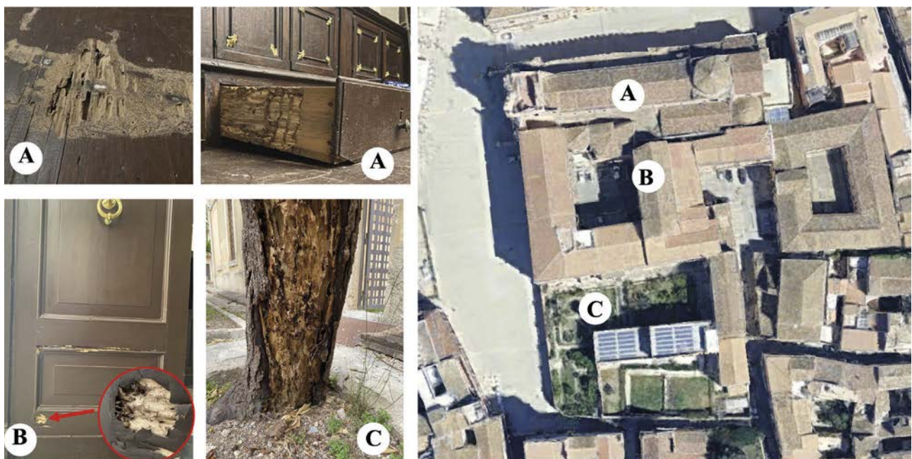
Fig 2. Danni da Reticulitermes. lucifugus e dislocazione degli stessi all'interno di un sito soggetto ad infestazione (la lettera nel cerchio indica la posizione nel sito): particolare di un cassetto e del pavimento della sacrestia (A); particolare di un portone (B); tronco d'albero nel giardino attiguo alla chiesa (C) (Cattedrale della Natività di Maria Santissima, Siracusa -foto Ezio Peri e Gaetano Matranga).
